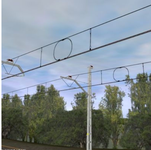
Figura 3.3. Cables del tipo C
