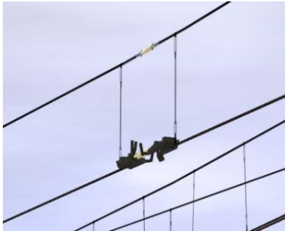
Figura 3.15. Aislador de sección
